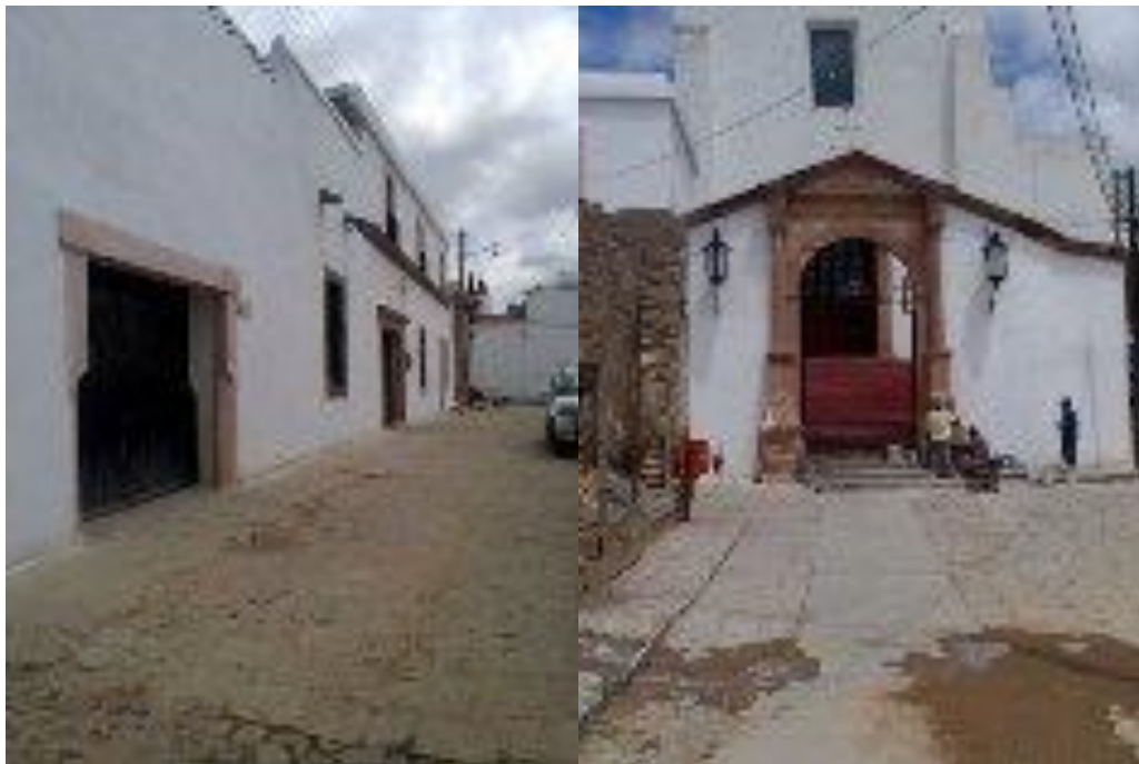
Figura 3. Izquierda: Entrada del aula de la parroquia de Mineral de Pozos. Derecha: Fachada principal de la parroquia de San Pedro Apóstol, Mineral de Pozos, San Luis de la Paz, Gto.
