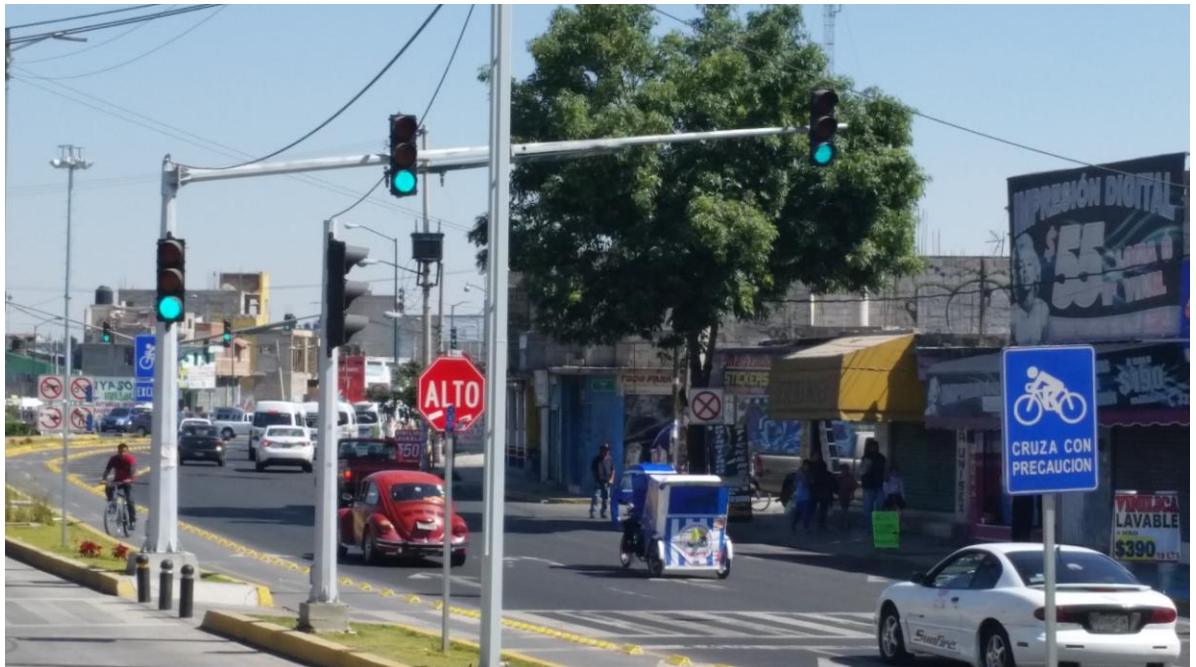
Señalética de las avenidas de acceso del Mexibús Línea 3. Estado de México, 2015
