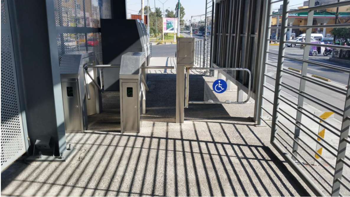
Entrada a las estaciones del Mexibús Línea 3. Estado de México, 2015
