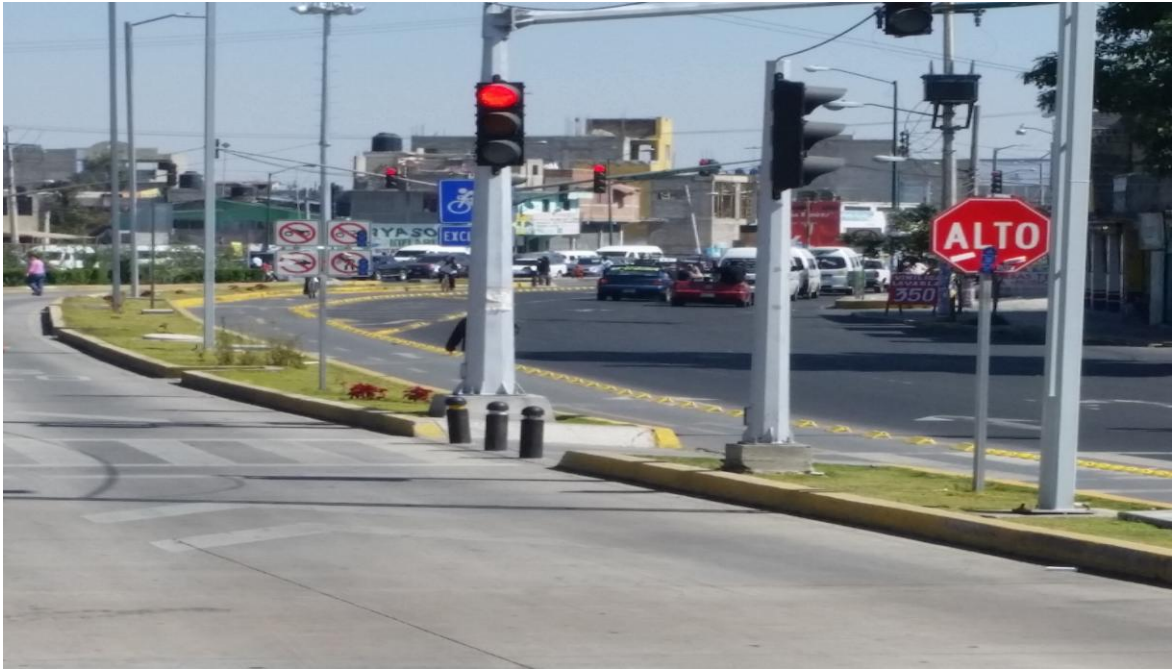
Acceso a las estaciones del Mexibús Línea 3. Estado de México, 2015
