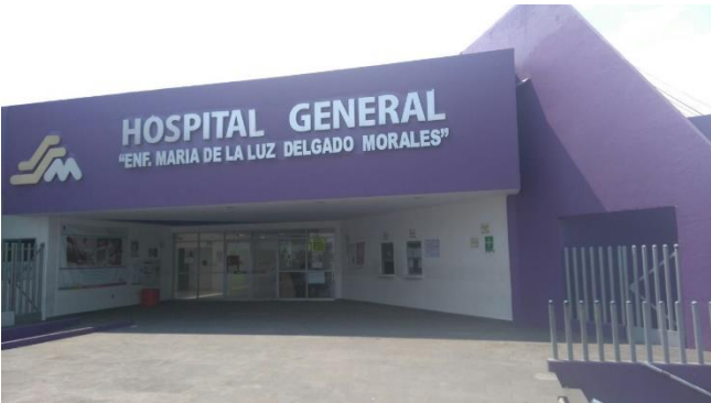
Fig. 10.- Entrada principal del HGT
