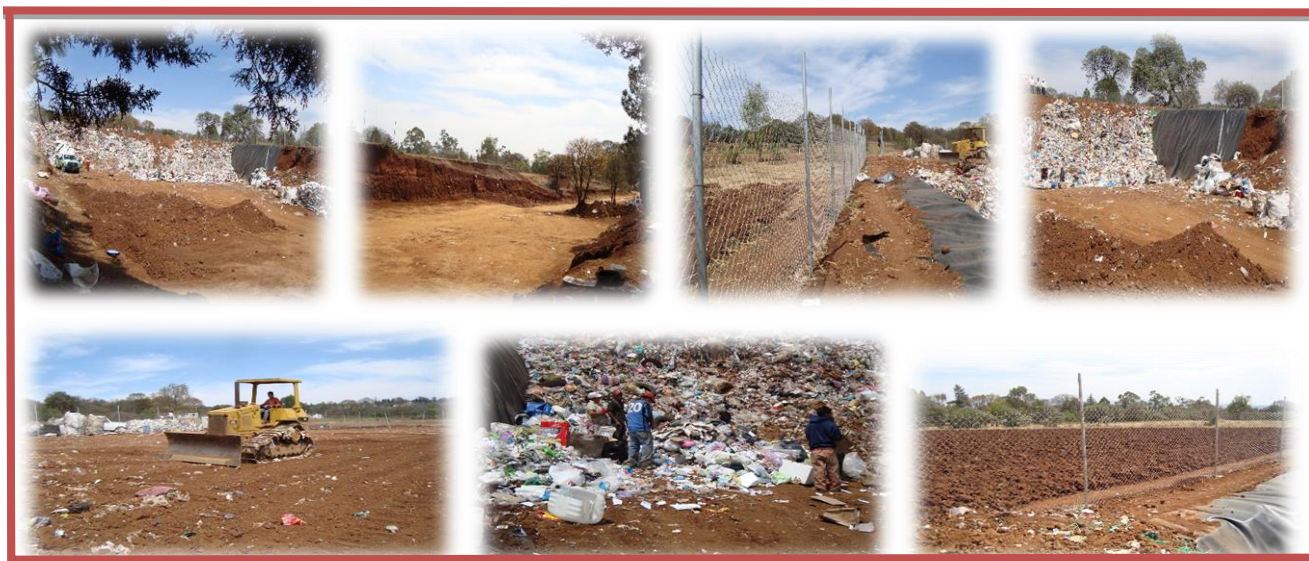
Imagen 2: Condiciones que guardaba sitio controlado en Agua Escondida en 2013.
